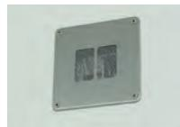
Jede Tiefkühlzelle ist mit einem Druckausgleichsventil ausgestattet.
