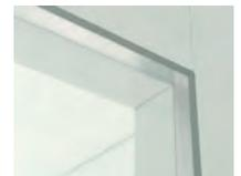
Die Kühlzellentüren sind mit einem Kälteunterbrecherprofil, die Tiefkühlraumtüren zusätzlich mit einer Rahmenheizung ausgestattet.
